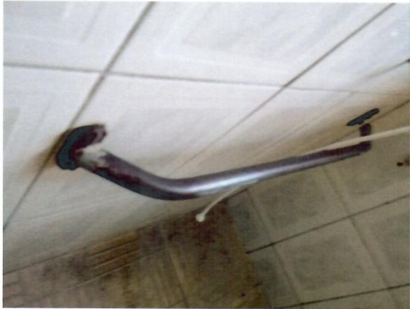
CONDIÇÕES GERAIS DOS BANHEIROS
