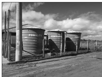
Figura 31 – Reservatórios - Sistema Village Fonte: Premier Engenharia, 2019.
