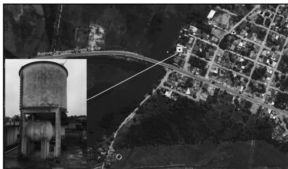
Figura 25 – Reservatório Sist. Guriri Fonte: Premier Engenharia, 2019.
