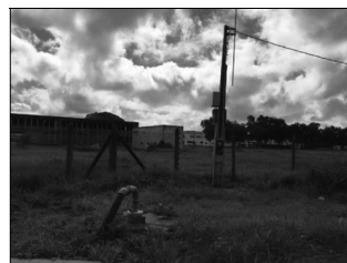
Figura 27 – Poço Principal - Sist. Litorâneo Fonte: Premier Engenharia, 2019.
