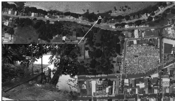
Figura 7 – Captação no Rio Cricaré Fonte: Premier Engenharia, 2019.
