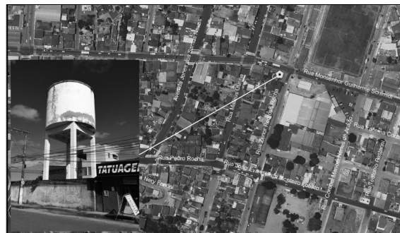
Figura 16 – Reservatório Sernamby Fonte: Premier Engenharia, 2019.
