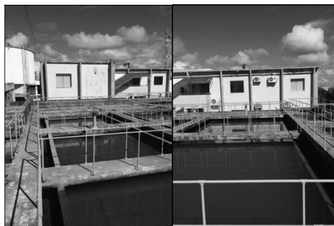
Figura 13 – Decantadores - ETA's 1 e 2 Fonte: Premier Engenharia, 2019.
