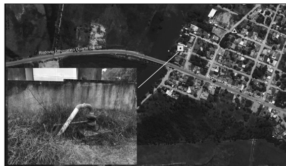
Figura 19 – Poço ETA Guriri Fonte: Premier Engenharia, 2019.
