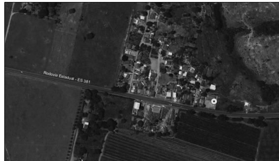
Figura 33 – Localização do Sistema Nossa Senhora de Guadalupe Fonte: Premier Engenharia, 2019.
