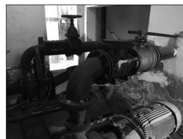
Figura 24 – Conjunto Motobomba - ERAT ETA Guriri Fonte: Premier Engenharia, 2019.
