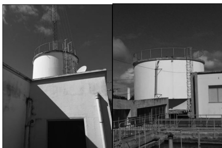
Figura 14 – Reservatórios - ETA's 1 e 2 Fonte: Premier Engenharia, 2019.
