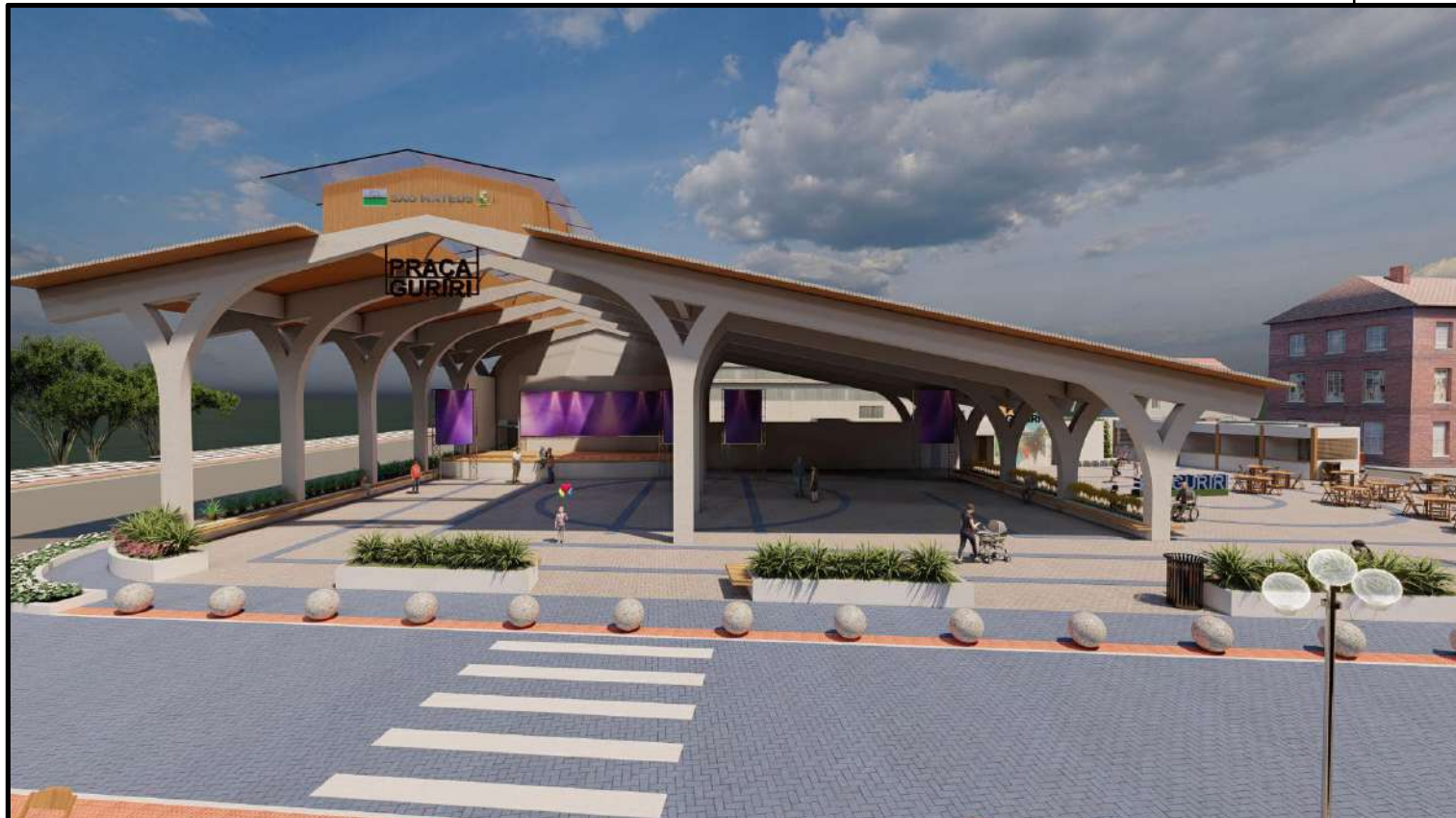
VISTA PRINCIPAL DA COBERTURA A PARTIR DA AV. GOV. EURICO VIEIRA DE REZENDE. COBERTURA COM ESCRUTURA DE CONCRETO E CLARABOIA CENTRAL. NAS LATERAIS DO GALPÃO OBSERVA-SE OS BANCOS E CANTEIROS COM PLANTAS. À DIREITA TEM-SE LOCAL PARA AMBULANTES COM ÁREA DE MESAS E, AO FUNDO, ESTRUTURA DE CAMARINS E BANHEIROS.
