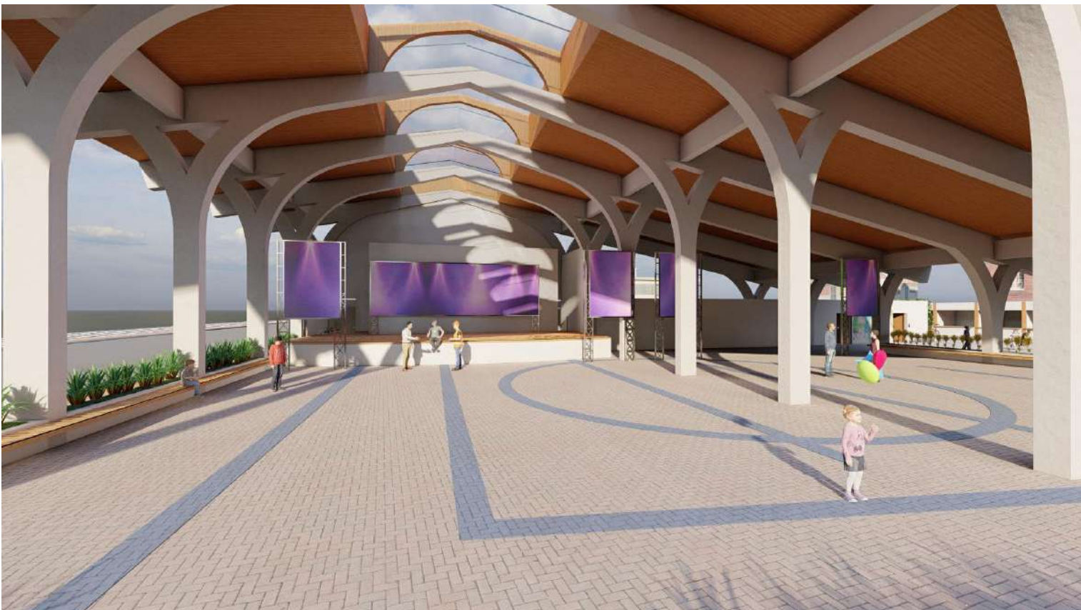
COBERTURA DO PALCO EM CONCRETO COM CLARABOIA CENTRAL. LATERAIS DA COBERTURA COM BANCOS E CANTEIROS.
